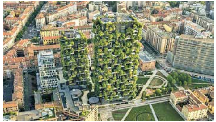
Figure 6: Bosco Verticale, Milan: Green Towers Source: Stefano Boeri Architetti. (n.d.)
